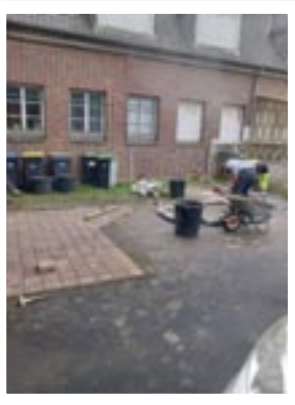
Aménagement du local à poubelles dans la cour de la mairie
