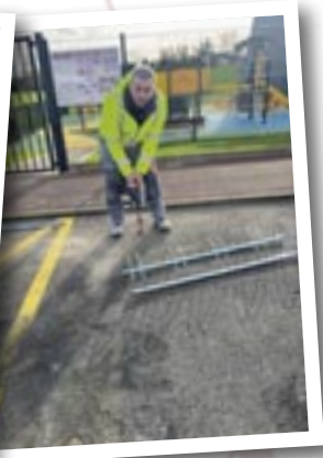
Pose de portique pour vélos et trottinettes à l'aire de jeux
