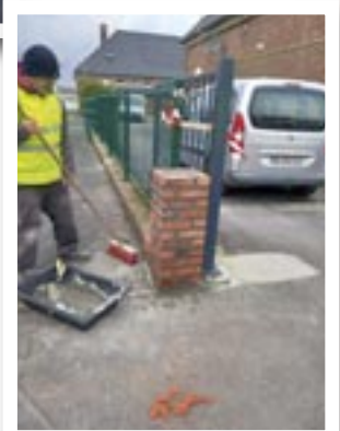
Réfection d'une pilasse en briques
