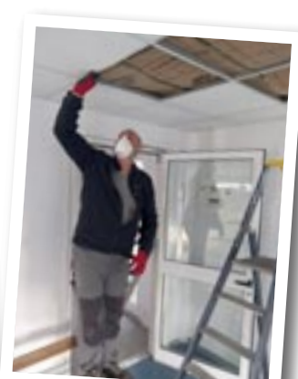
Pose de laines de verre et de dalles à l'école Joliot Curie
